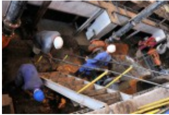
En reparaciones los centrales que en Las Tunas harán zafra
