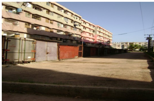
Foto III: Transformaciones constructivas en la planta baja de los edificios: “Los Garajes”
