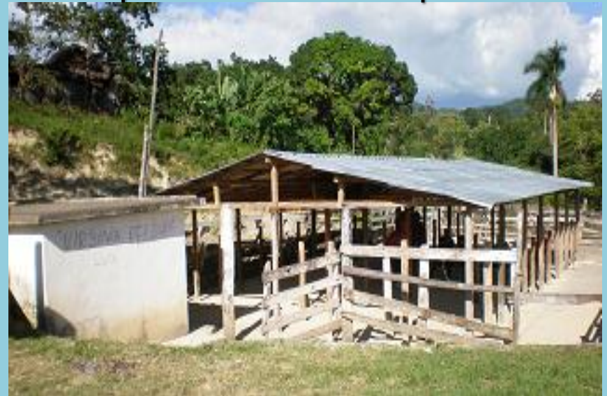
Reparación de la Vaquería
